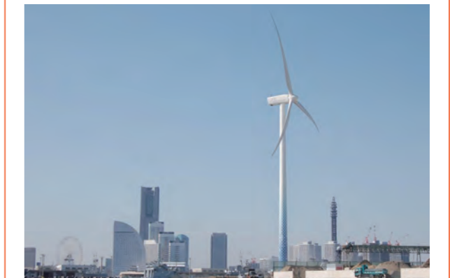
横浜市風力発電所(ハマウィング)
